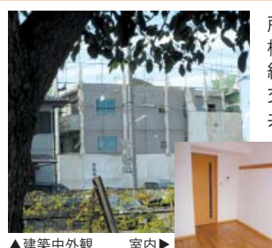
▲建築中外観 室内▶
