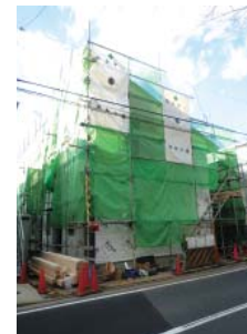
▲建設中の外観
