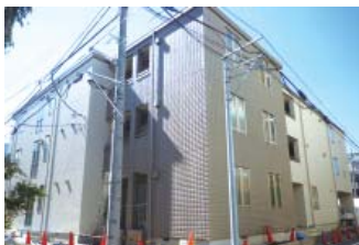
▲建設中のマンション外観
